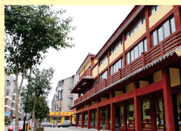
相府新街现铺实景
