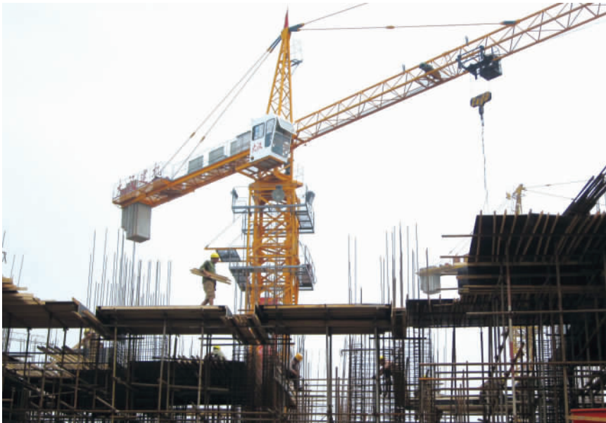
工人正在加紧施工。 岳亚光 摄
