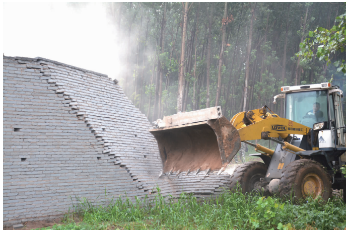
图为拆除林地旁的一处砖混结构房屋,挖掘机刚一接触,近乎整面墙体便轰然倒塌。
