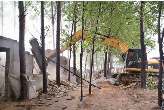
图为对林地内的一处违章建筑进行拆除。
