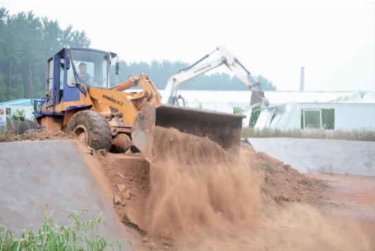
图为对田地内的一处“鱼塘”进行拆除,不远处房屋内的玉米清晰可见。
