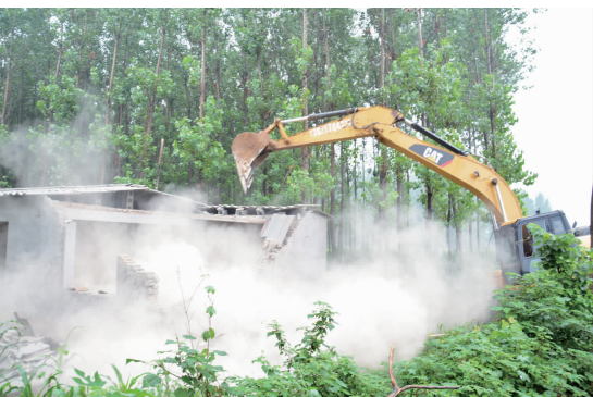
伴随着拆除,土黄色粉尘四处弥漫。
