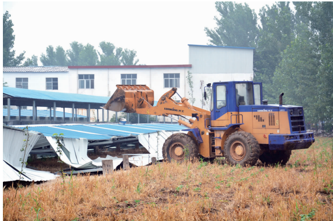
图为本次行动中拆除的第一座违章建筑,该建筑为轻钢结构,修建于田地之上。
