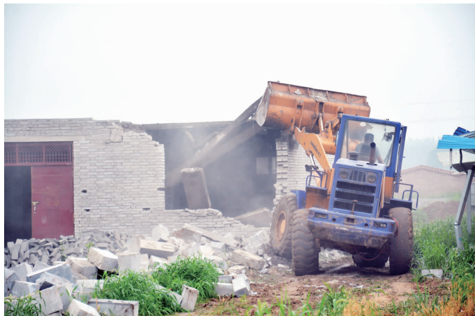
砖混结构房屋拆除过程中,砖头落地后摔成一块一块,少有还粘连在一起的。
