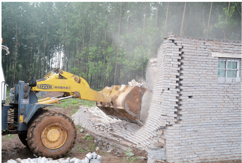
6 月 25 日上午，我区组织联合执法队，对高桥营街道办事处大罗庄社区私搭乱建建筑进行了集中依法拆除，成功拆除各类违章建筑共计 28000 平方米。 图为集中执法现场。 李思远 摄 ▶▶ 详见 4 版
